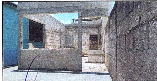
Foto 6: AVANCE DE REMOZAMIENTO DE LA COCINA .
